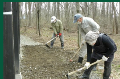
家の周りの表土除去
